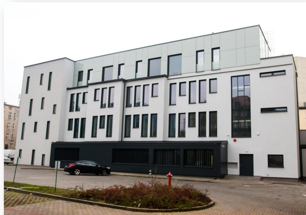
Po modernizacji budynku
