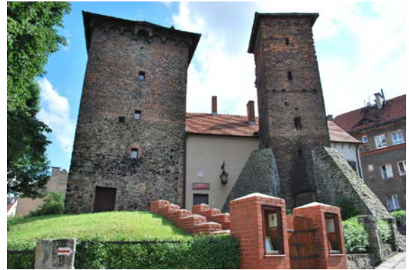
Prudnik. Baszty murów miejskich z XV w. Prudnik. Towers of the 15 th -century town walls Prudnik. Městské opevnění z 15. stol.
